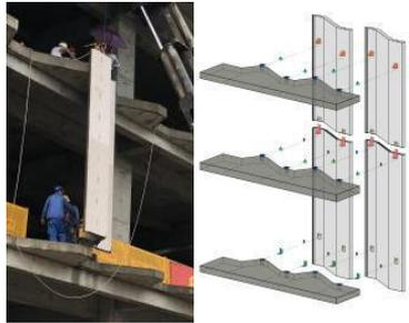
图 C.0.1-5 点支承式装配式外墙板
