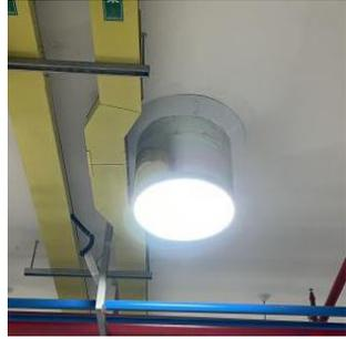
图 C.0.1-3 地下室导光管（左：室外；右：地下室室内）
