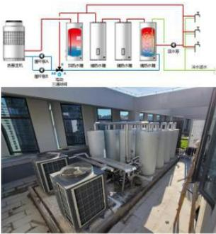
图 C.0.1-11 空气源热泵热水系统
