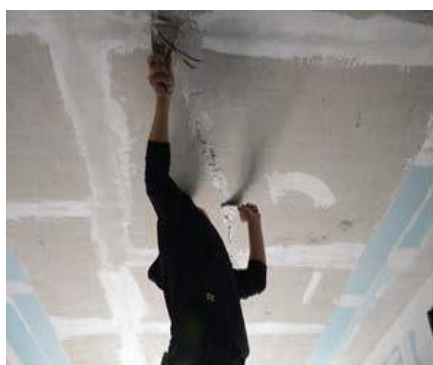
图 6.3.1-1 封堵顶棚缝隙示例
