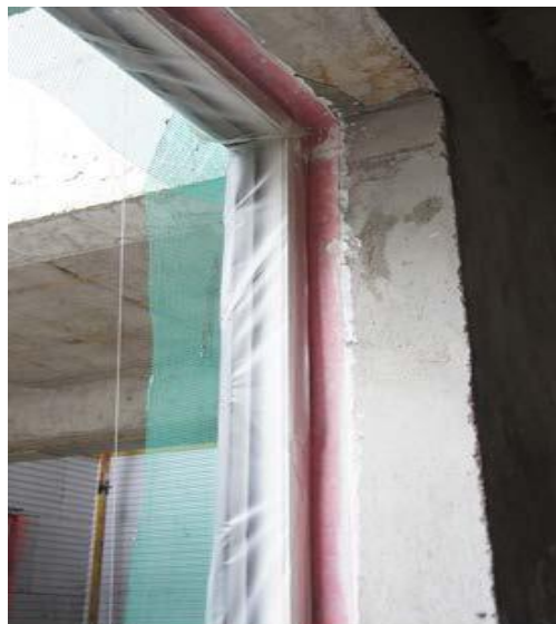
图 6.2.5-2 外窗内侧密封布示例
