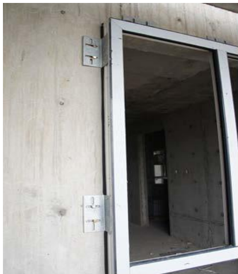
图 6.2.5-1 外窗安装示例
