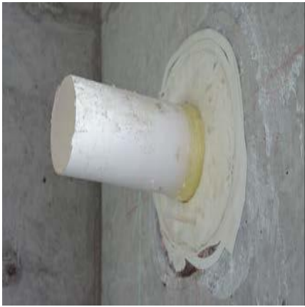
图 6.2.3-1 穿墙套管保温示例
