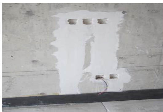
图 6.3.1-2 电线管路用石膏封堵缝隙示例
