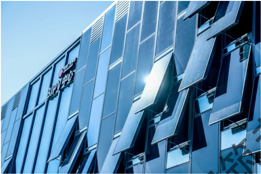
图 2-12 安装在建筑幕墙上的光伏组件
