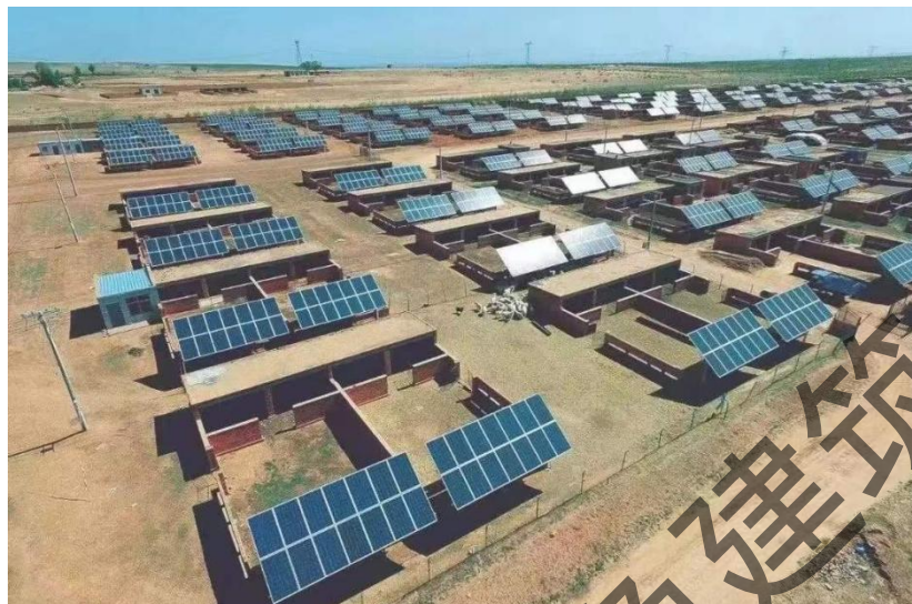
图 2-11 安装在墙面上的光伏组件
