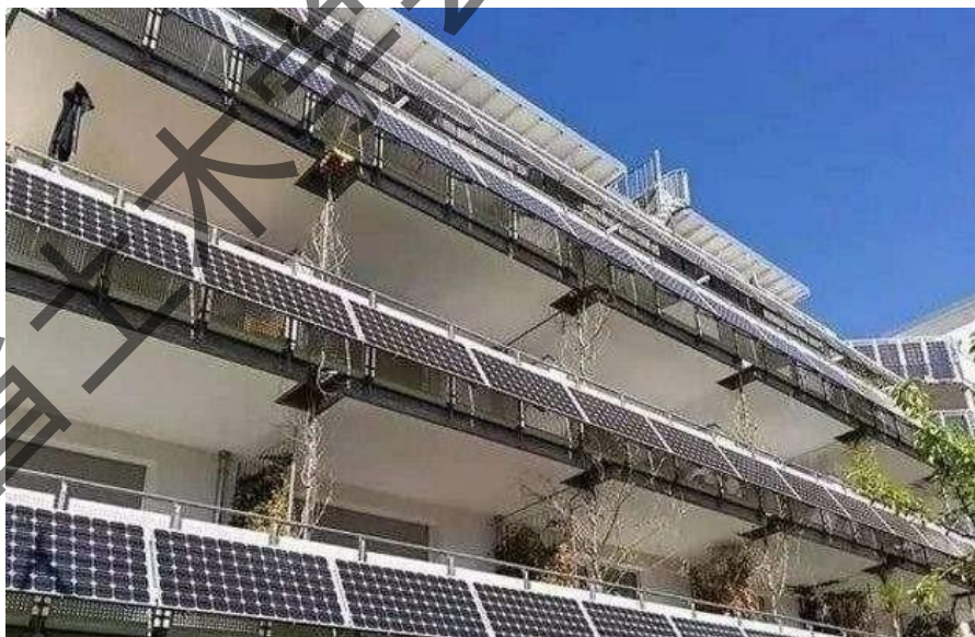
图 2-10 安装在阳台上的光伏组件
