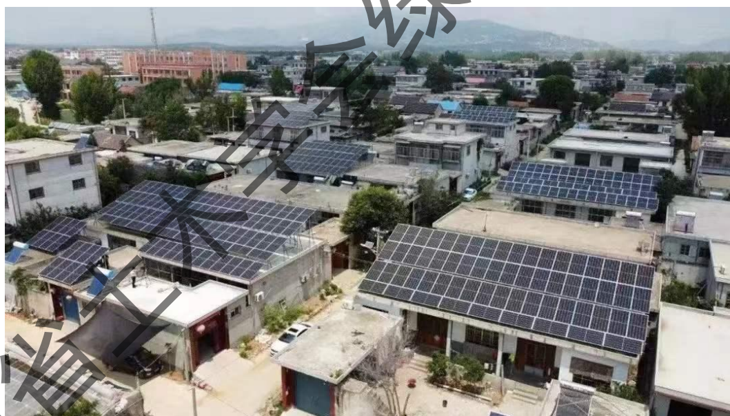
图 2-8 安装在平屋面的光伏组件
