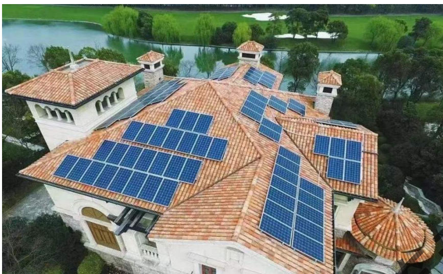
图 2-9 安装在坡面的光伏组件
